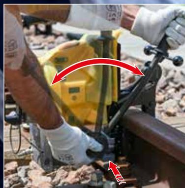
**Leva di avanzamento regolabile per meglio adattarsi all'altezza dell'operatore o dell'applicazione**
