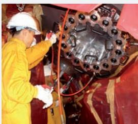
Plusieurs vérins segment sont assemblés sur une bride, ce qui permet le serrage simultané de plusieurs boulons. La répartition égale de précharge conduit à une haute précision – utile sur brides ANSI ou en zone sensible comme une centrale nucléaire.
