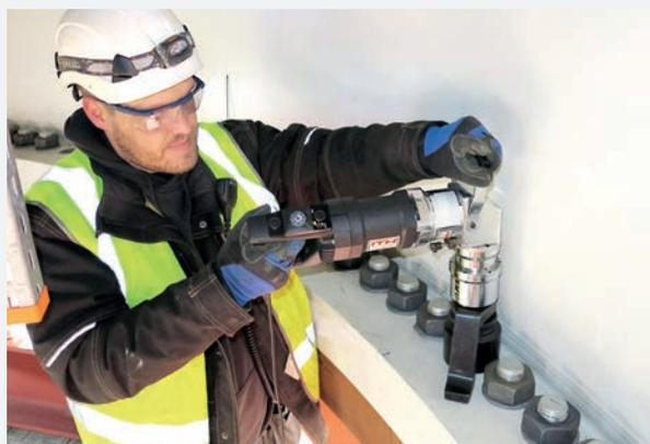
Les versions coudées des visseuses ITH ITH sont habituellement utilisées pour des applications où l'espace est limité. Sur la photo les boulons M48 (1 7/8") d'un segment de tour d'éolienne sont pré-serrés à l'aide d'une EDS w.
