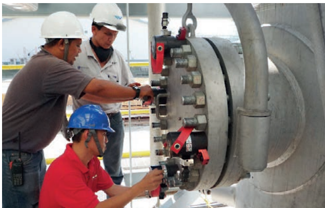
Vorbereitung einer ANSI-Flanschverschraubung mit 4 x ITH SSZ Typ ES (ITH Multi Tensioning).
