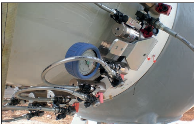
Blattlagerverschraubung einer Windenergieanlage mit ITH Multi Tensioning.
