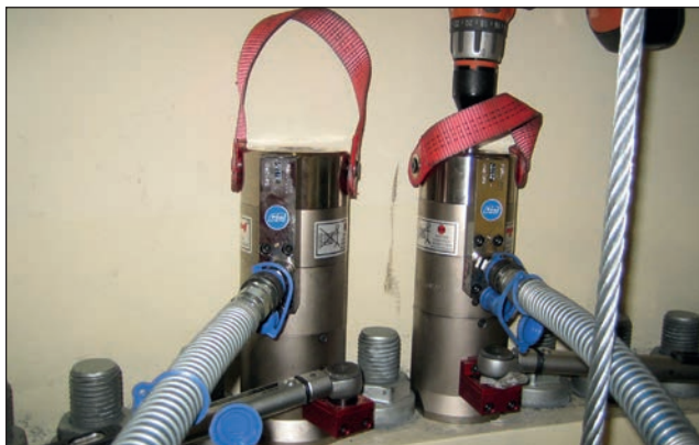
Gleichmäßiges Vorspannen der Turmsegmentschrauben einer Windenergieanlage mit 2 x ITH SSZ Typ MS.
