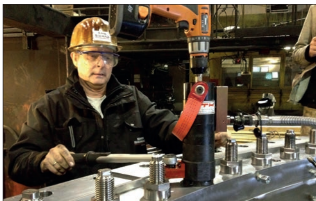
Verschraubung eines Pfannendrehturms mit ITH SSZ und ITH Rundmuttern RMS.
