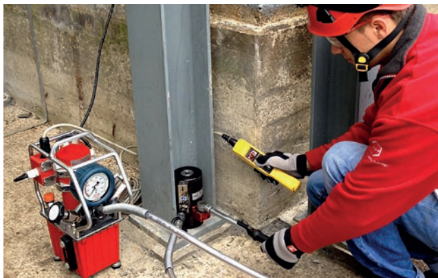
Fundamentverschraubung eines Stahlbauträgers mit ITH SSZ Typ ES 20 - 200 und dem ITH Hochdruckaggregat Micro-MAX.
