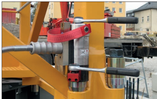
Turmstoß-Verschraubung eines Baukrans mit ITH SSZ Typ MS.
