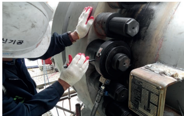
Typische ANSI-Flanschverschraubung an einem Wärmetauscher mit ITH SSZ Typ SES.
